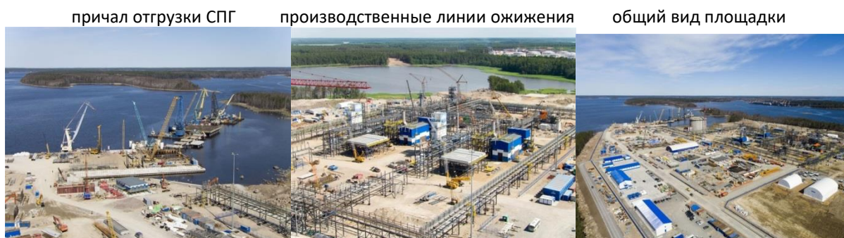
Рисунок 41 - Фотографии площадки строительства «Высоцк СПГ»
